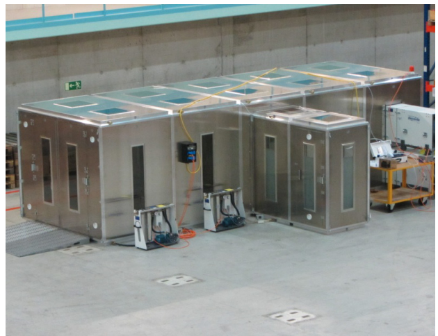
Schwarzbereich für die Verfestigung von Asbest
