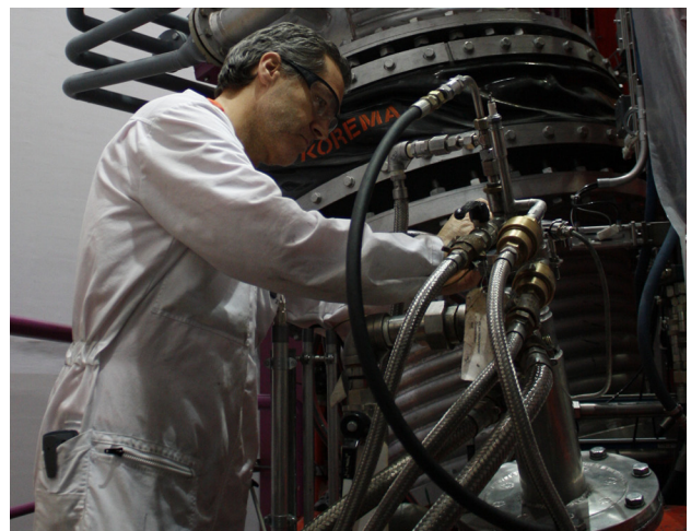
Revisionsarbeiten am Hilfsbrenner der Plasma-Anlage
