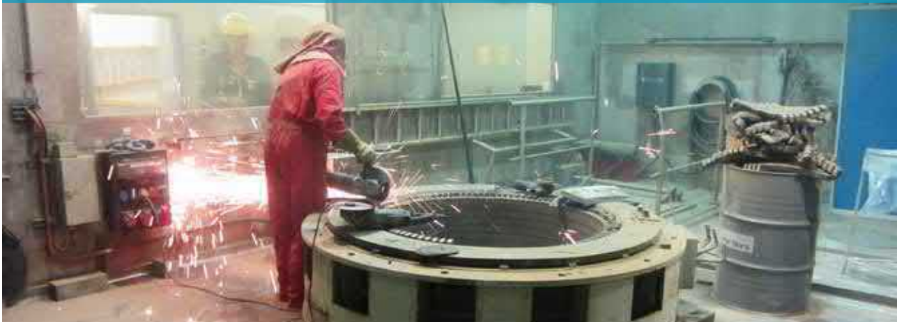
Zerlegung von Grosskomponenten in der Beta-Gamma-Box
