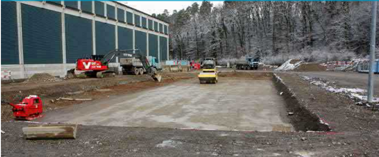
Bau Lagerhalle I zur Lagerung von konventionellem Material
